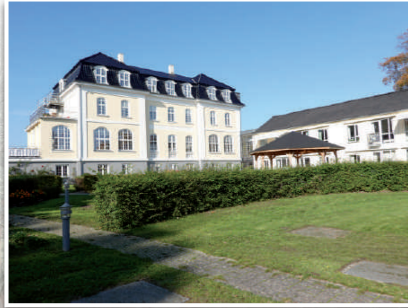
Ejendom i Humlebæk Energioptimering med vinduer og døre fra Obbekjær.
